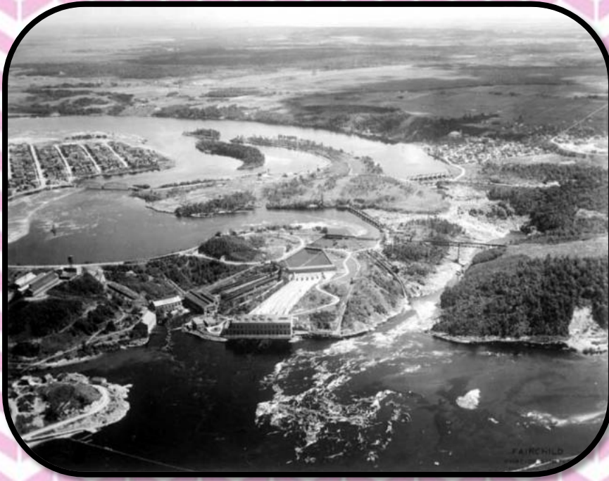
L'électricité (barrage hydroélectrique)
